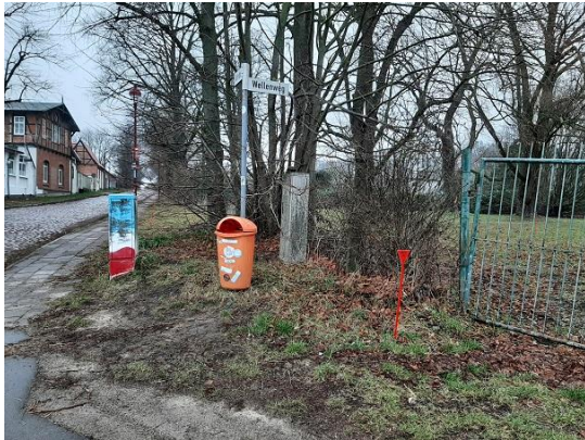
Roter Markierstab: Ansatzpunkt BS 10/25, Ausbau zum Grundwasserpegel RFP 1/25 (Foto: Inros Lackner SE, 05.02.2025)
